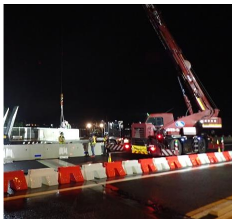
＜仮設防護柵撤去＞
