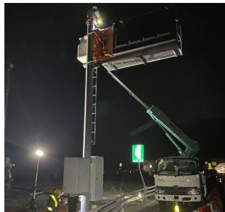
＜路側設備撤去＞
