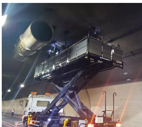
＜トンネル換気設備撤去＞
