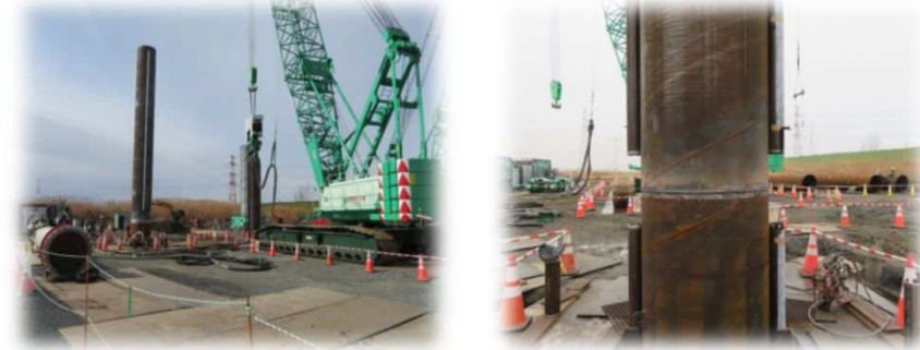
▲施工状況写真
