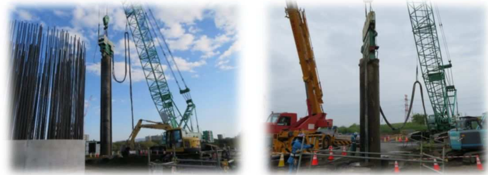
▲施工状況写真
