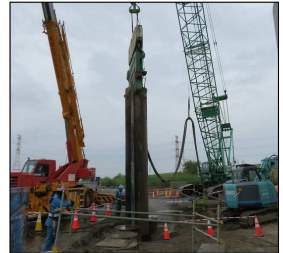
▲鋼管矢板の引抜状況
