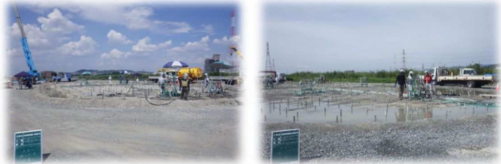
▲施工状況写真
