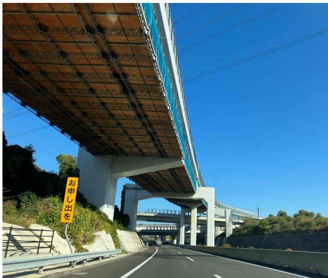
《吊足場解体前》
