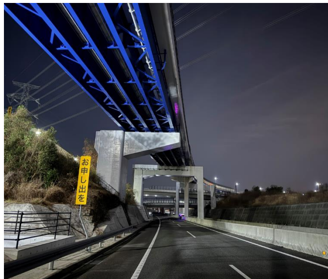
《吊足場解体後》
