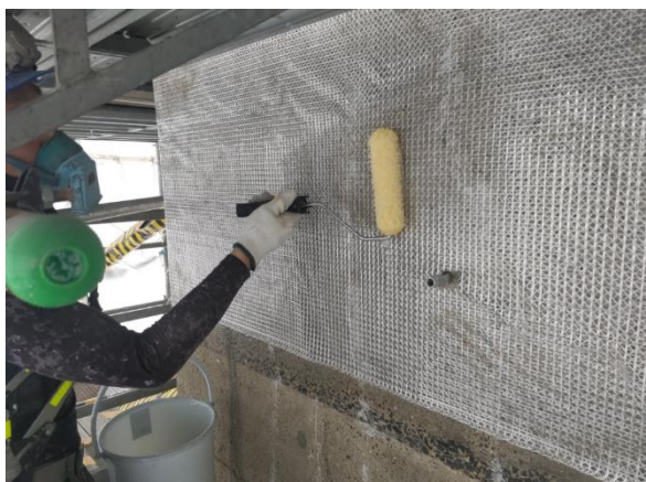
<はく落対策工>
