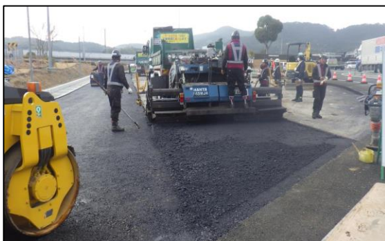
【拡幅部_舗装施工状況】
