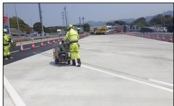
【既設駐車場部_路面標示施工状況】
