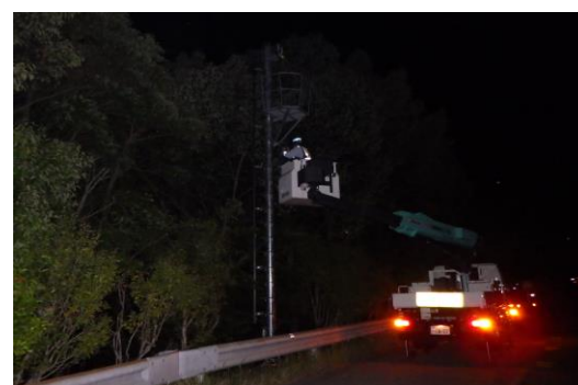
〈道路設備構造点検〉
