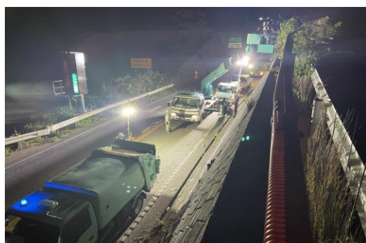
〈樹木伐採作業〉
