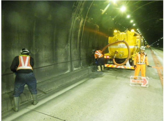
《トンネル内維持修繕作業(水路清掃)》
