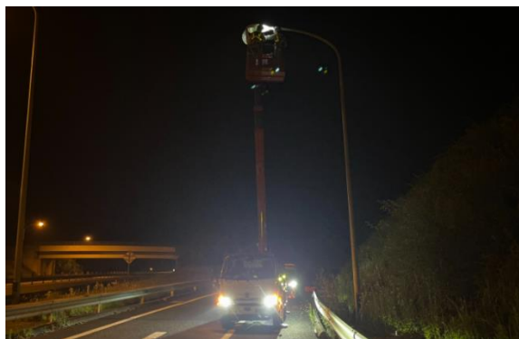
＜道路照明点検作業＞
