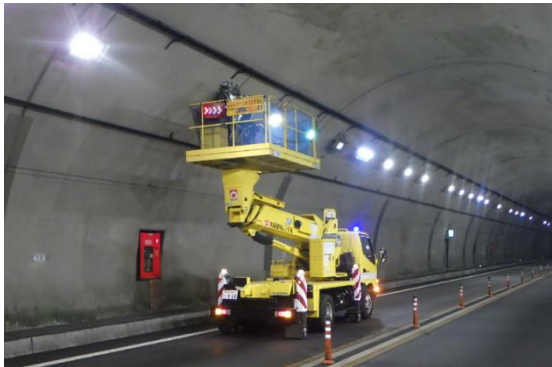
＜トンネル照明点検作業＞
