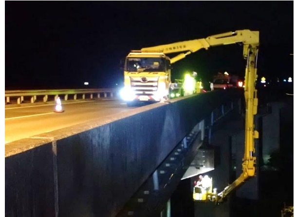
< 構造物点検（橋梁） >
