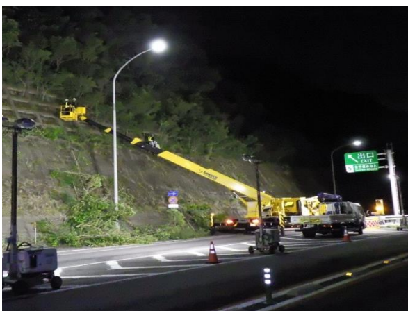
< 樹木伐採作業 >
