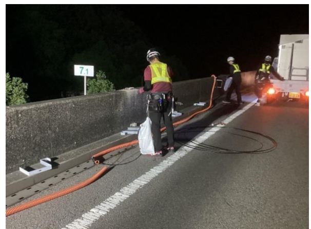
< 通信設備工事 >
