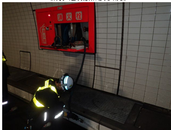
《消火設備点検状況》
