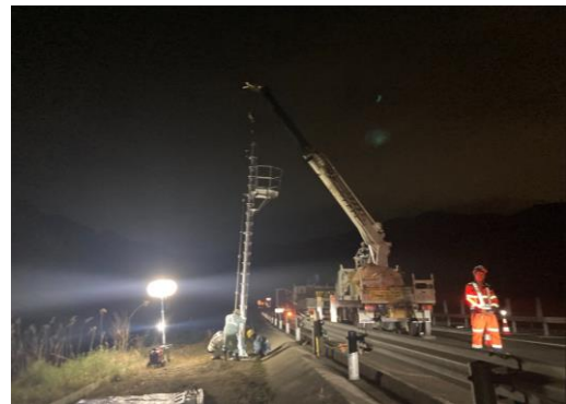
〈通信設備工事〉
