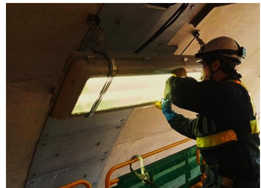
〈トンネル照明点検〉
