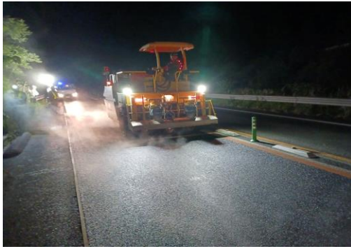
〈舗装補修工事〉
