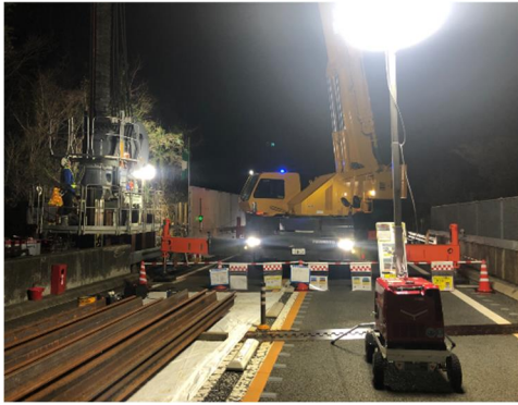
土留め鋼矢板打設
