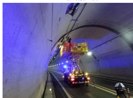
トンネル設備更新
