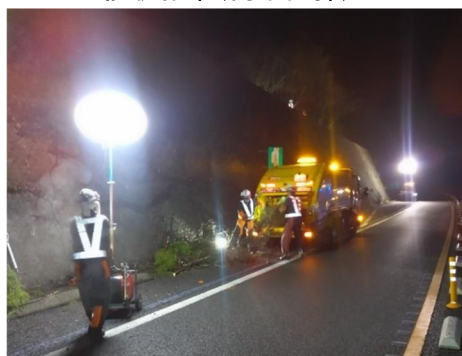
植栽作業(樹木伐採)
