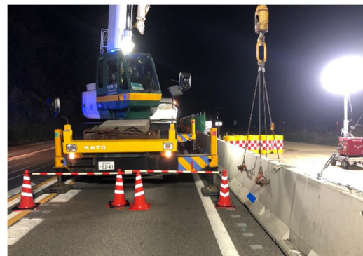
仮設防護柵設置
