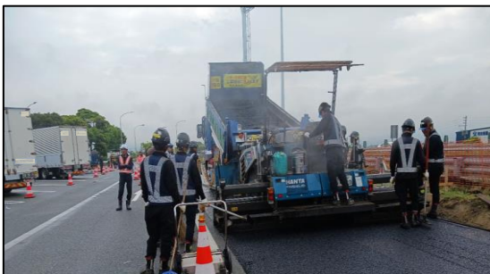
【舗装施工状況】
