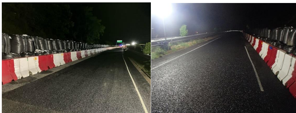
＜簡易防護柵設置および路面補修完了＞
