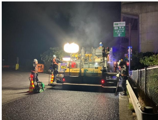
《舗装補修作業状況》
