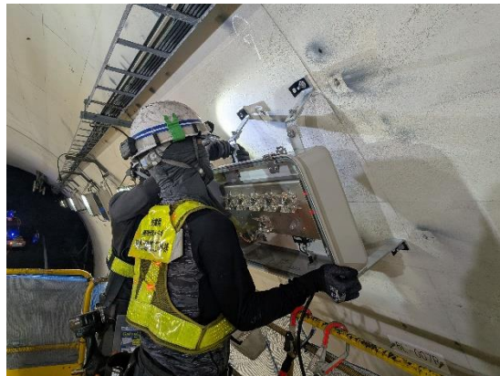
《トンネル照明取替作業状況》
