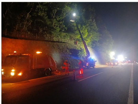
植栽作業(樹木伐採)
