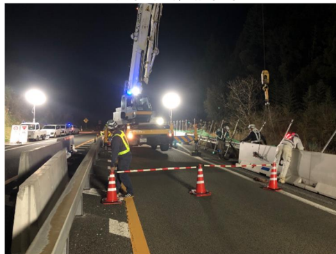
仮設防護柵設置
