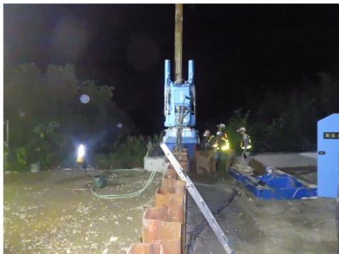
土留め鋼矢板引抜き
