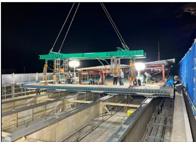
③新設床版の設置作業状況
