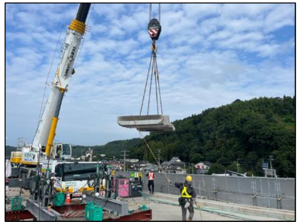
②損傷した床版の撤去作業状況
