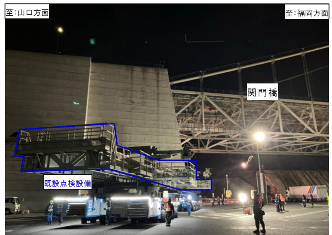
《撤去後運搬状況》
