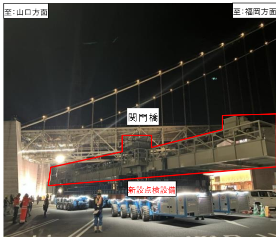
《(1)新設点検設備運搬状況》
