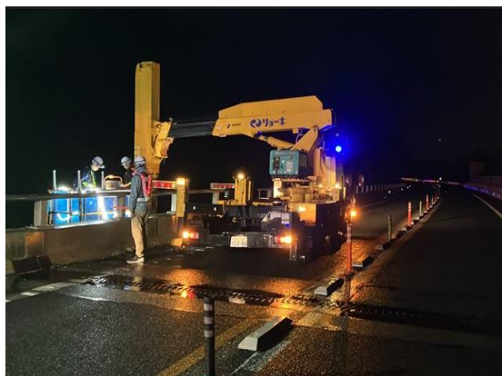
《橋梁点検状況》
