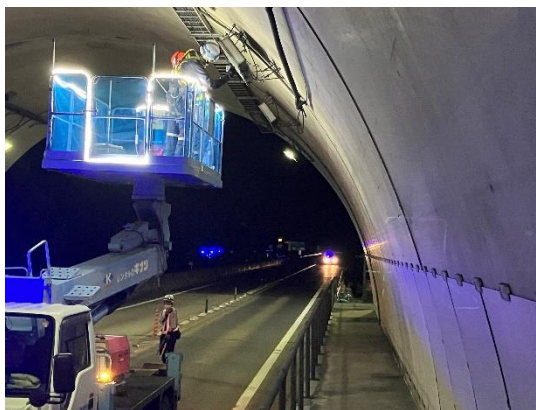
《照明点検状況》
