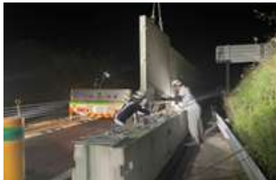
<バリアウォール移設作業>
