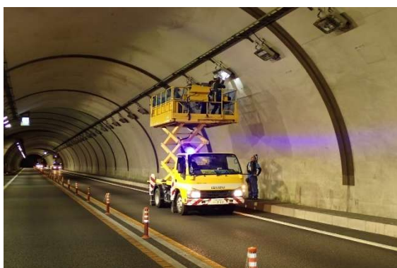
<トンネル照明点検作業>
