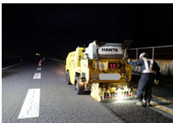
<舗装補修工事>
