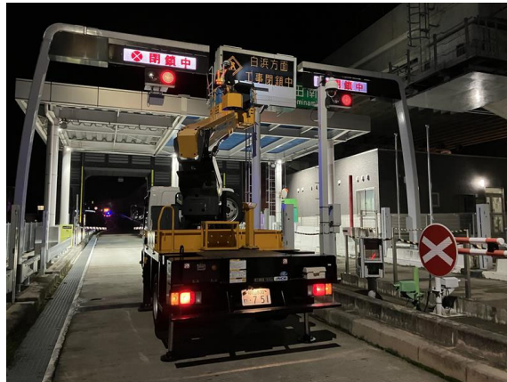
《情報板点検状況》
