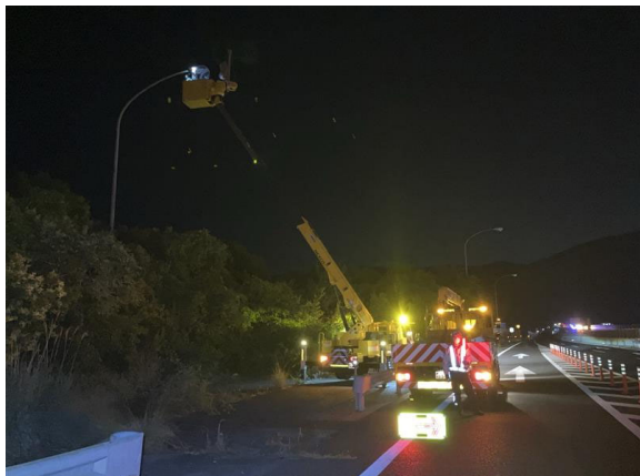
《照明点検状況》
