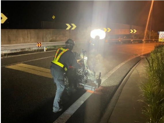
《路面標示作業状況》
