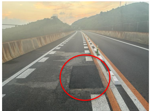
《補修箇所② 施工後》
