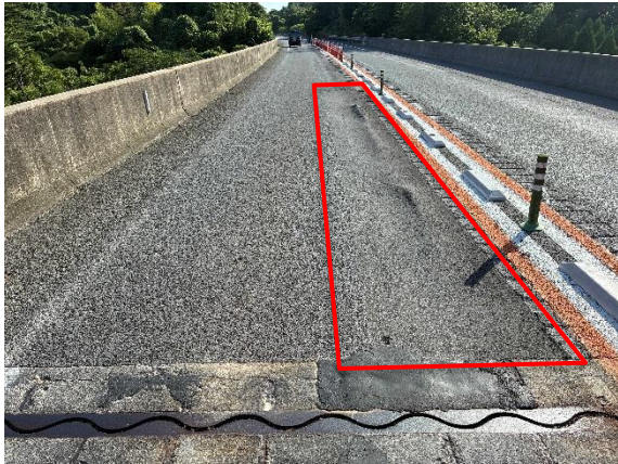
《補修箇所① 施工前》
