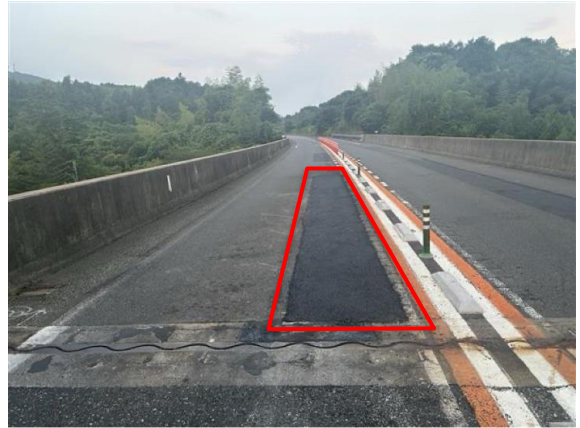
《補修箇所① 施工後》
