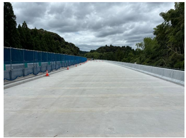
床版取替 施工後（床版防水工事施工前）
