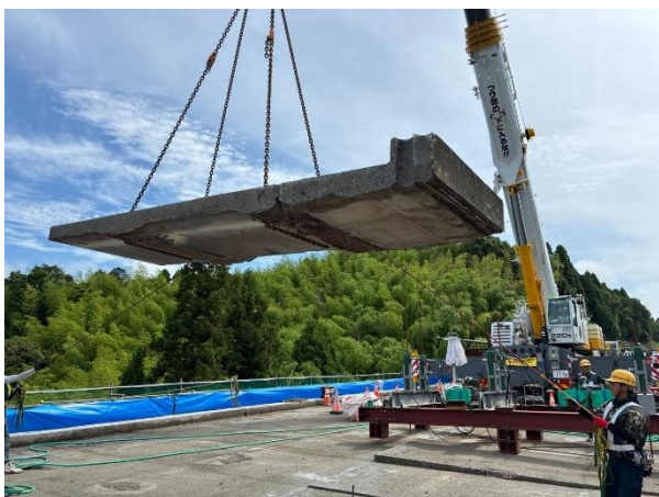
損傷した床版の撤去作業状況
