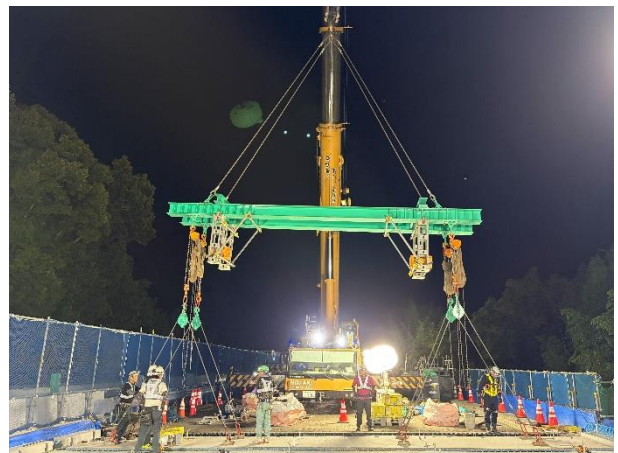
新設床版の設置作業状況
