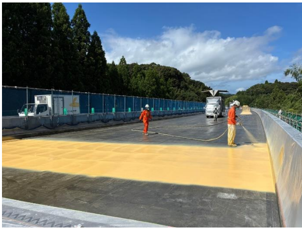
床版防水工事の作業状況
