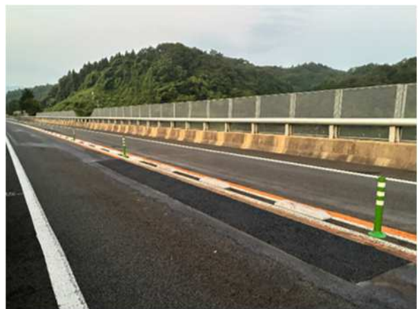
《補修箇所① 施工後》
