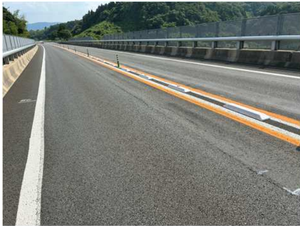
《補修箇所① 施工前》
