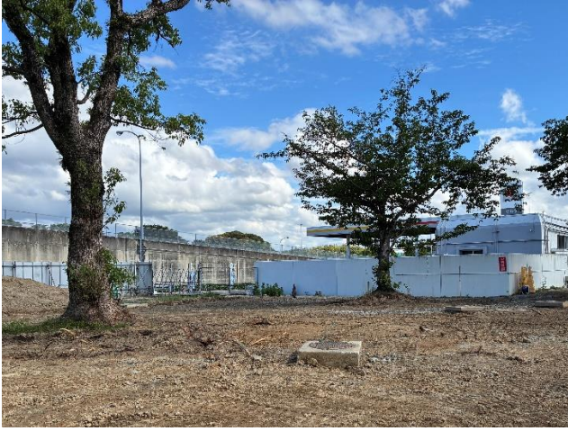
《ドッグラン造成中》
