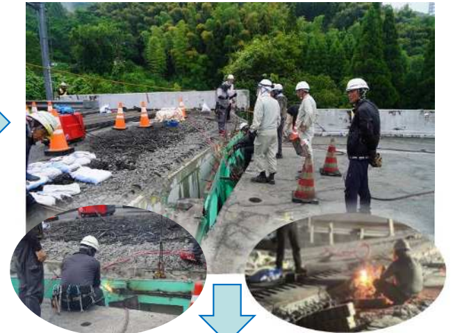
床版損傷部 応急復旧
