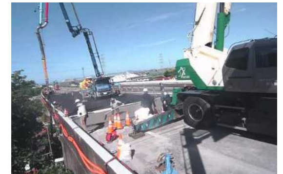
床版損傷部 応急復旧
