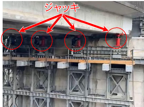
ジャッキアップ・鋼製支保工設置
