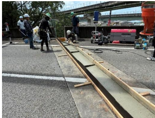
遊間部コンクリート打設
