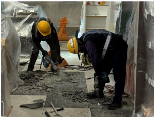
応急復旧作業
