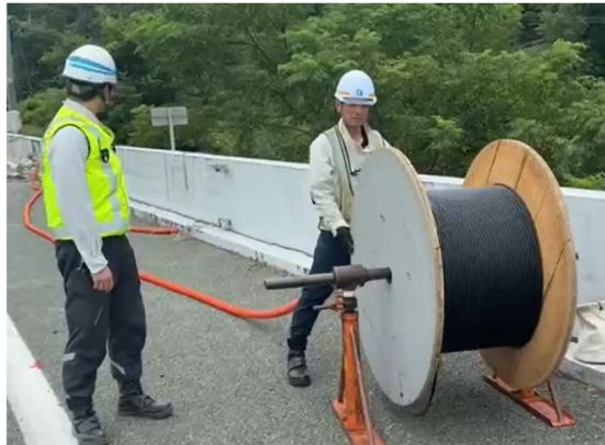
仮設ケーブル入線
