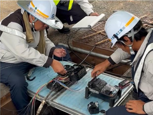
通信ケーブル接続作業
