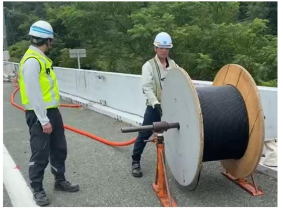
仮設ケーブル入線
