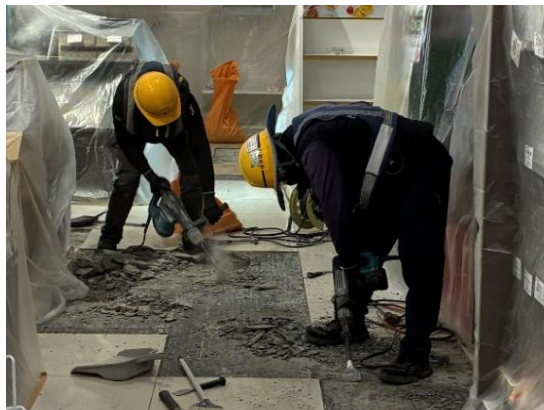
応急復旧作業
