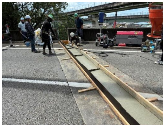
遊間部コンクリート打設
