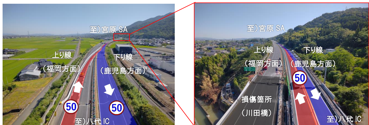
対面通行区間(KP211.4~KP212.9)の状況
