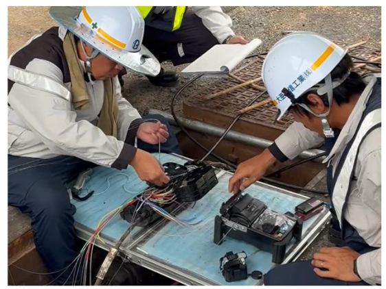
通信ケーブル接続作業
