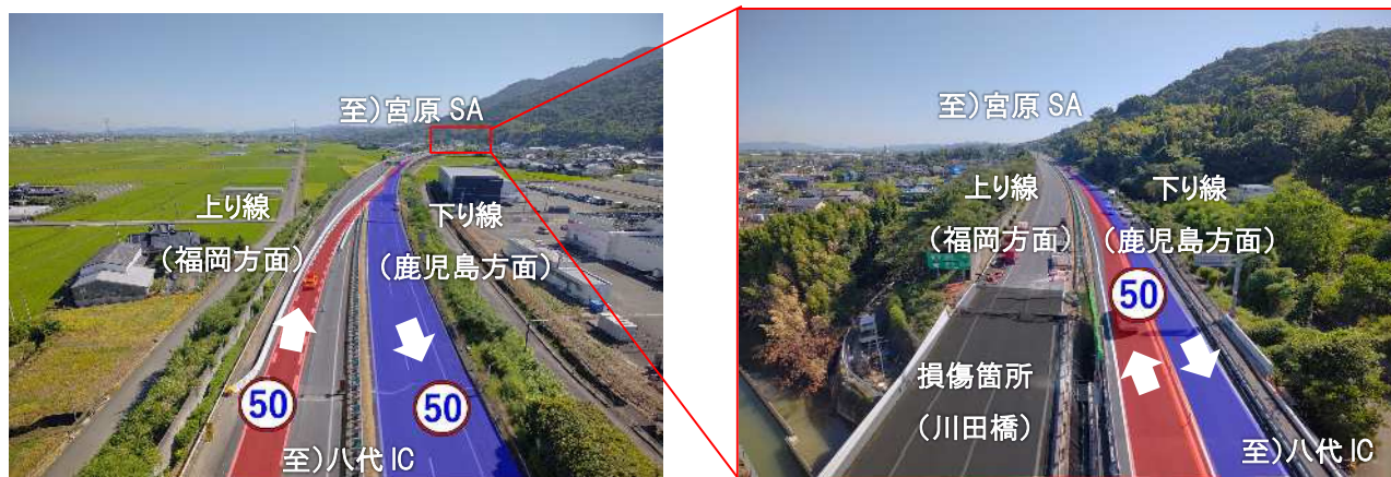
対面通行区間(KP211.4～KP212.9)の状況
