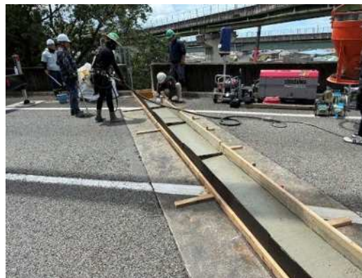
遊間部コンクリート打設
