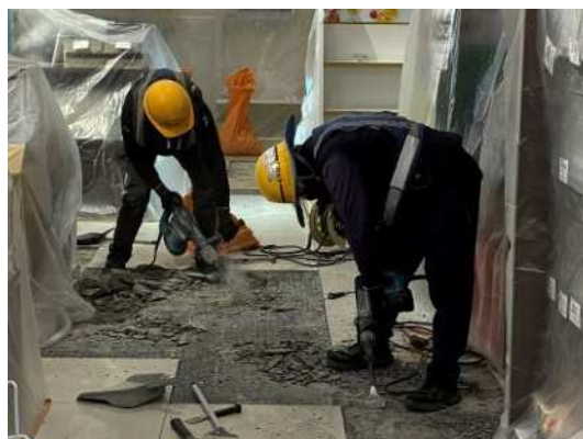
応急復旧作業
