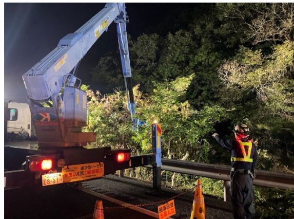
《支障木伐採作業状況》
