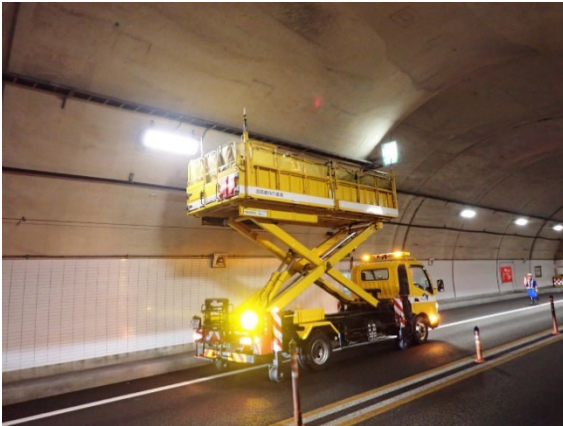
《トンネル内設備点検作業状況》
