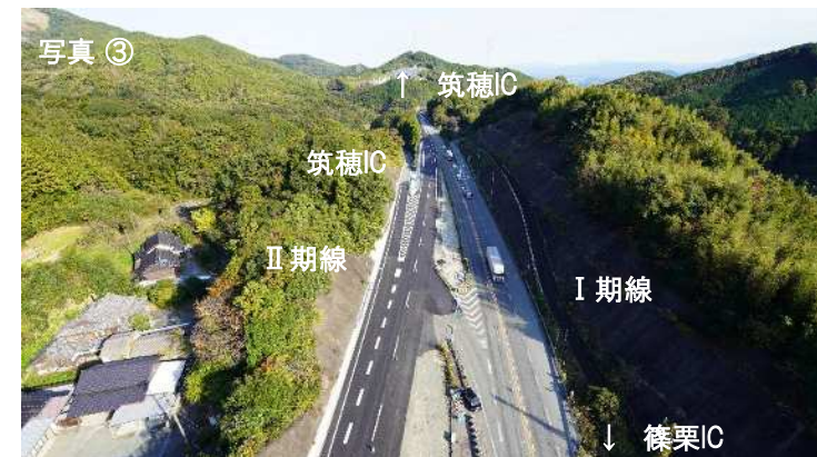
筑穂IC周辺進捗状況
