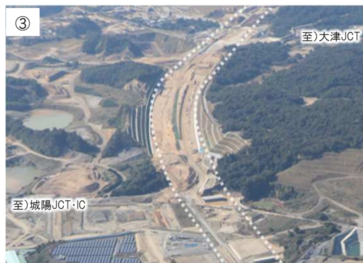
城陽市域土工部の整備状況
