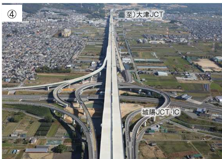
城陽高架橋の整備状況
