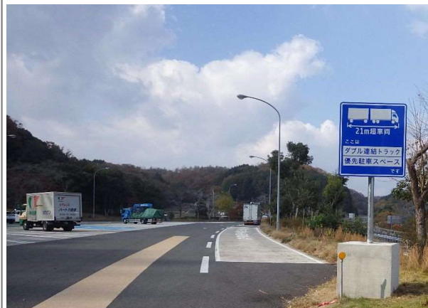
写真-1 E2A 中国道 江の川PA(下り線)
