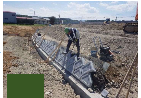
胴込め（コンクリート）
