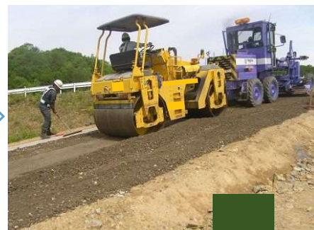
簡易舗装路盤工 (転圧)
