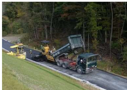
簡易舗装工（敷均し）
