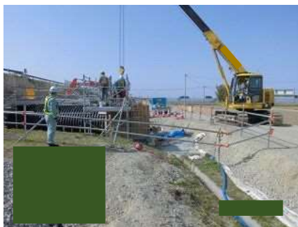
コンクリート打設①
