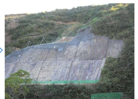
モルタル吹付
