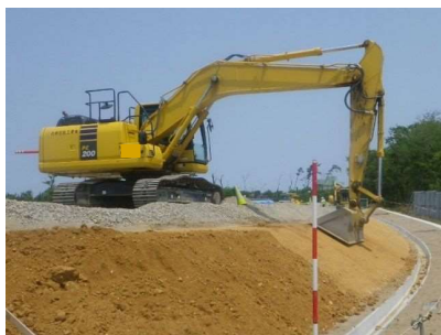
盛土のり面仕上げ（削取り）
