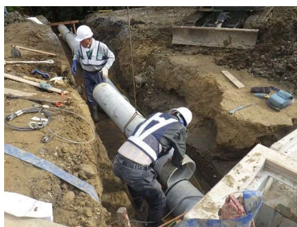
用排水管設置
