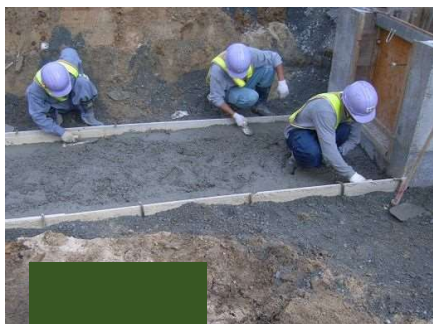
均しコンクリート打設
