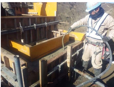
コンクリート打設
