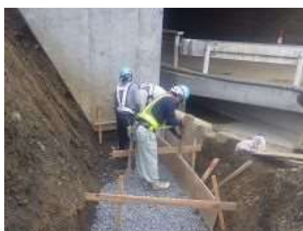
型枠製作・組立て
