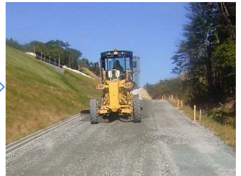
簡易舗装路盤工
