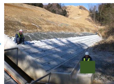
コンクリートブロック張り
