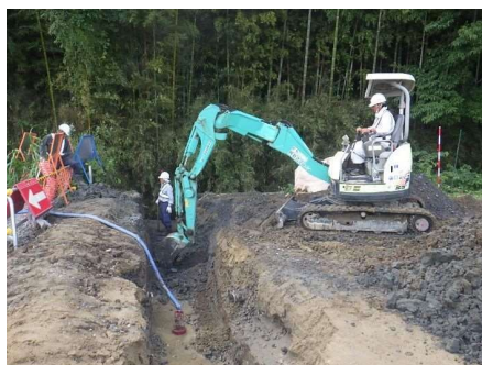
掘削・整正（床付）
