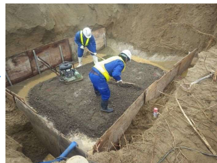
基礎材敷均し・締固め
