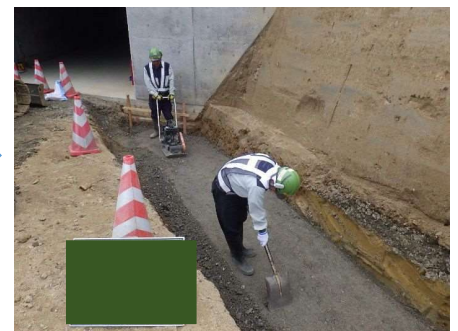
基礎材敷均し・締固め
