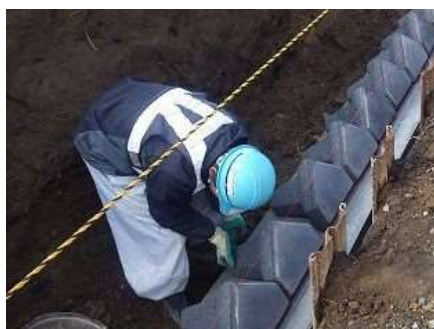
コンクリートブロック積み①
