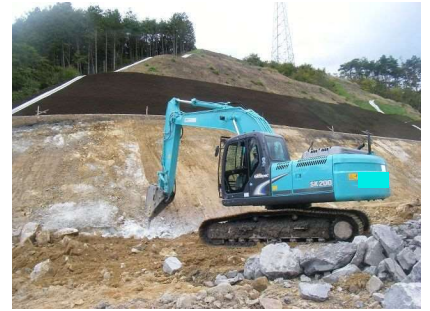
切土のり面仕上げ（硬岩）
