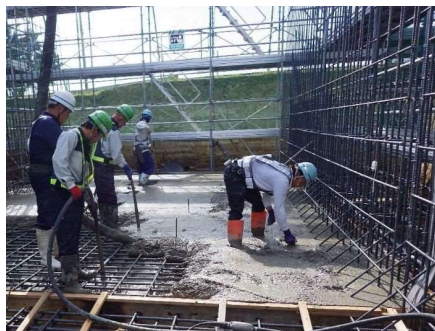
底版コンクリート打設
