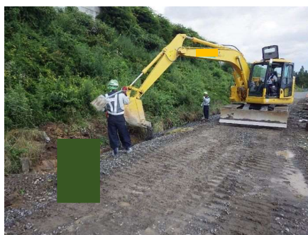
掘削・整正（床付）
