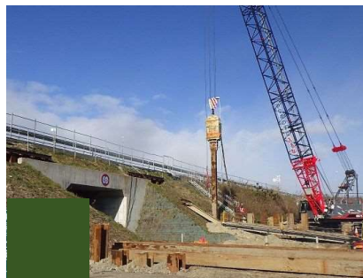
打込み（H型鋼）
