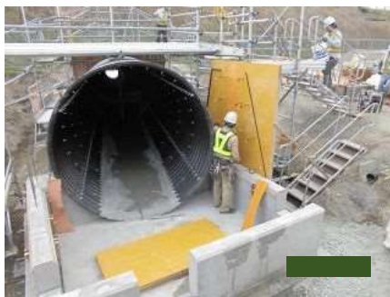
型枠組立①
