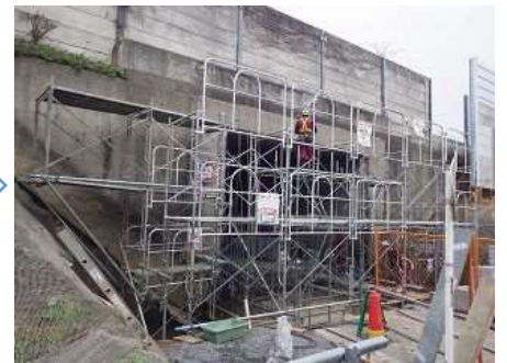
足場・支保設置
