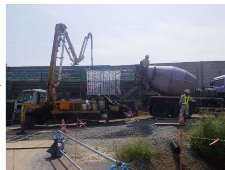
コンクリート打設・養生
