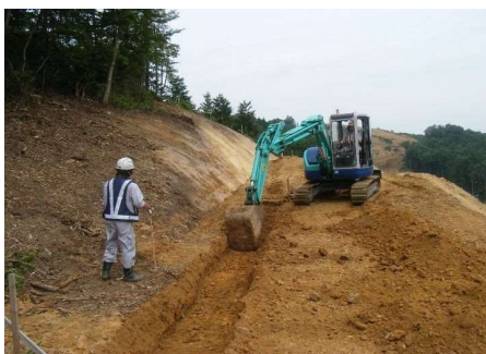
掘削・整正（床付）
