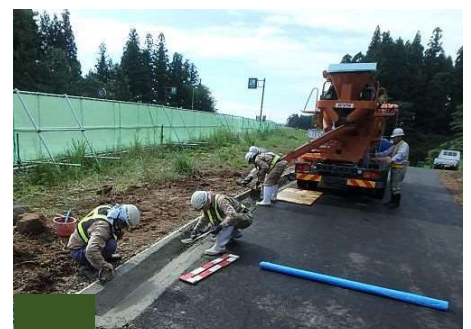
コンクリート打設
