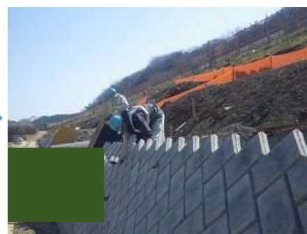
コンクリートブロック積み②
