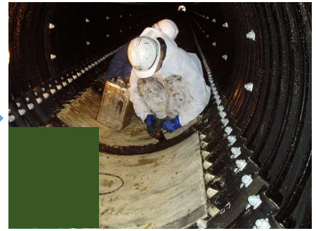
パイプ組立（目地仕上げ）
