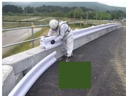
レール等設置
