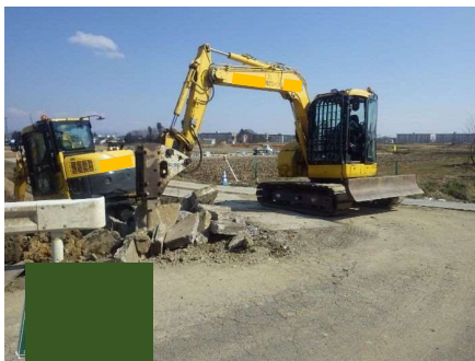
取壊し（大型ブレーカ）
