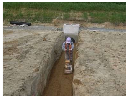
基礎材敷均し・締固め
