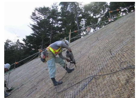
アンカーピン設置
