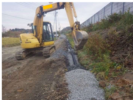
フィルター材設置
