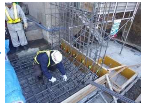
底板鉄筋加工・組立て
