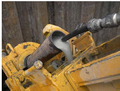
グラウト注入
