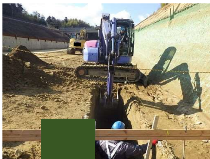
掘削・整正 (床付)
