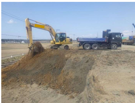
掘削・積み込み
