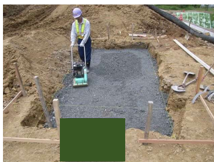
基礎材敷均し・締固め
