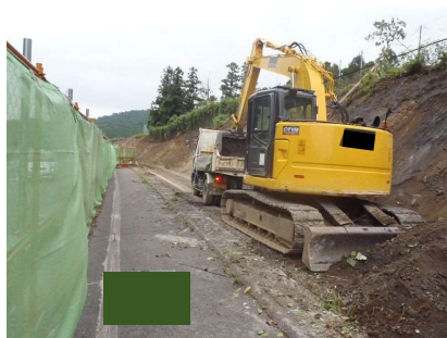
掘削・積込み
