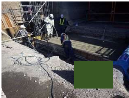
底版コンクリート打設
