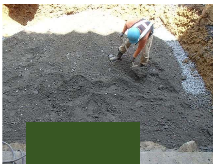
基礎材敷均し・締固め
