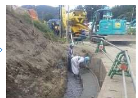
コンクリート打設
