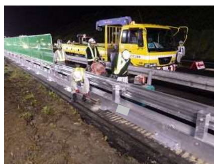
固定用アンカーピン打込み
