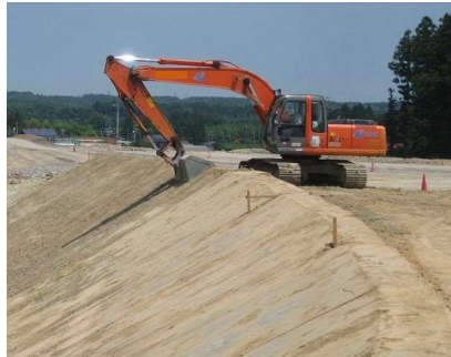
盛土のり面仕上げ（削取り）
