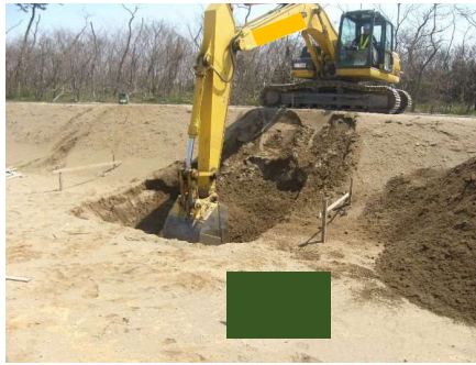
掘削・整正（床付）
