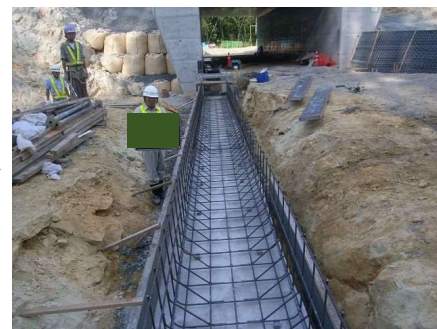
鉄筋加工・組立て
