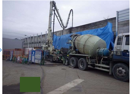
コンクリート打設・養生
