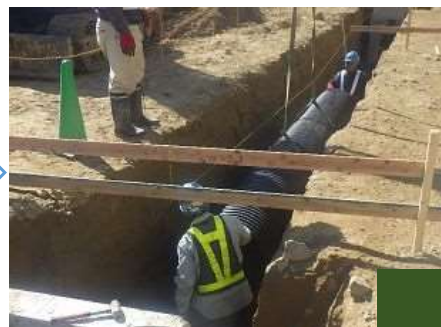
用排水管設置
