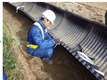
パイプ組立（ボトムセクション）
