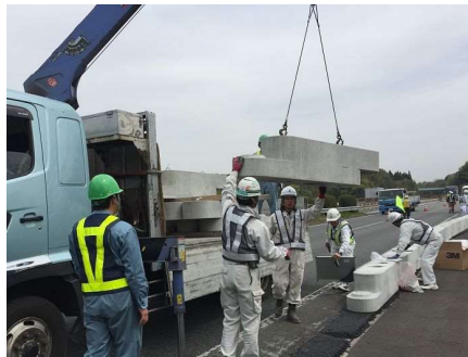
連続基礎ブロック設置
