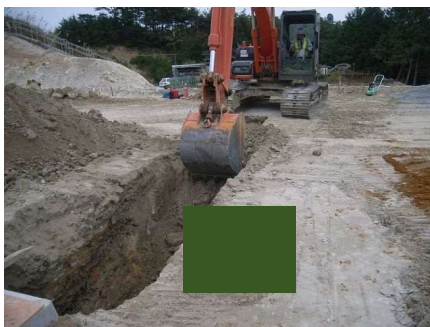
掘削・整正 (床付)
