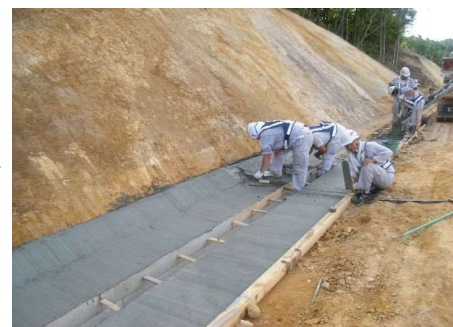
コンクリート打設
