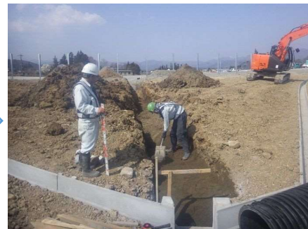
基礎材敷均し・締固め
