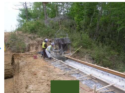
天端コンクリート打設
