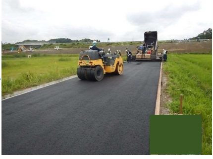
簡易舗装工（締固め）
