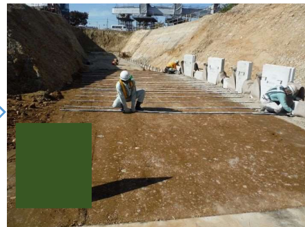
補強材設置
