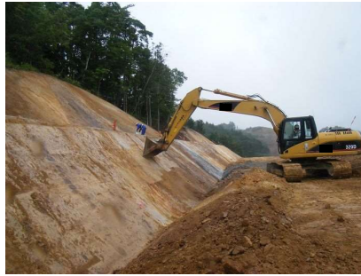
切土のり面仕上げ（土砂）
