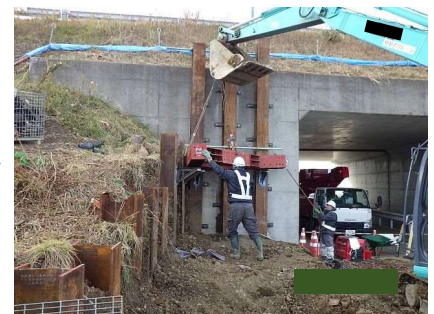
鋼製山留材設置
