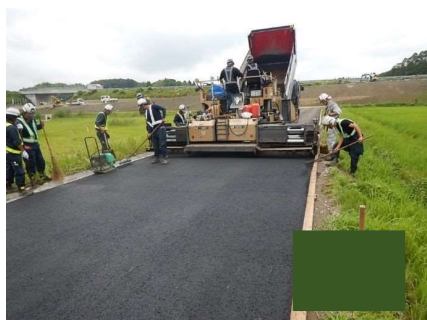
簡易舗装工（敷均し）
