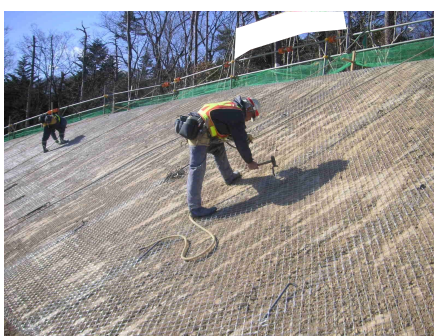
アンカーピン設置
