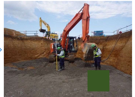
基礎材敷均し
