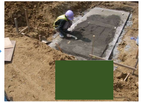
敷モルタル設置
