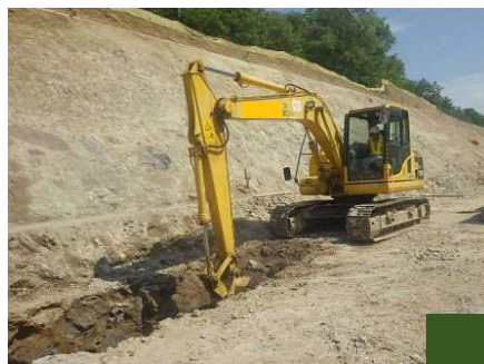
掘削・整正（床付）
