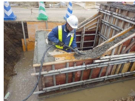
コンクリート打設
