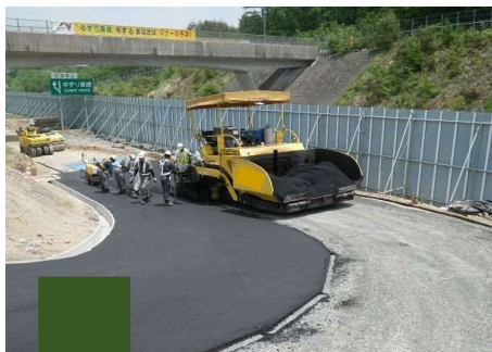
簡易舗装工 (敷均し)
