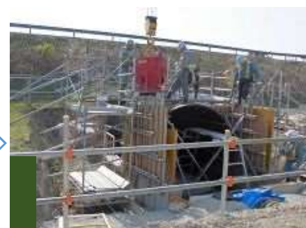
コンクリート打設②
