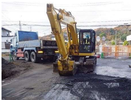
舗装版取壊し
