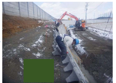
コンクリートブロック積み②
