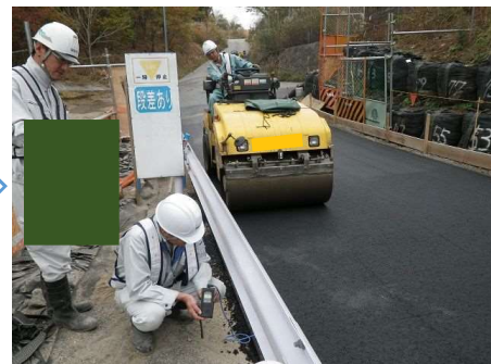
簡易舗装工 (締めめ)
