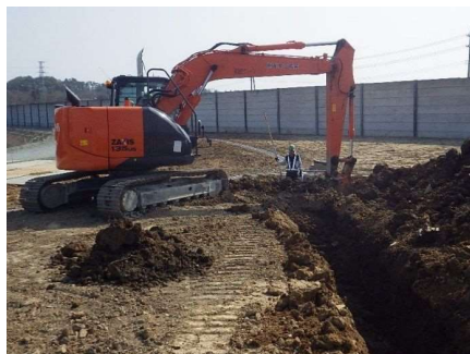
掘削・整正（床付）
