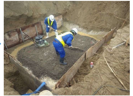
基礎材敷均し・締固め
