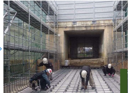
底版鉄筋加工・組立て
