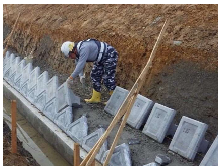
コンクリートブロック積み①
