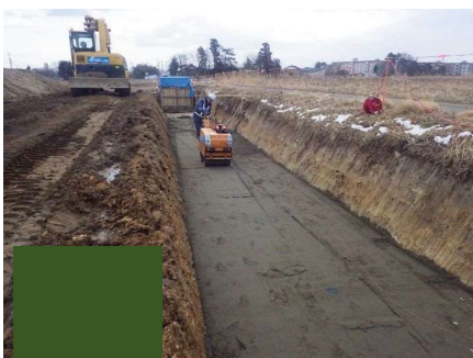
基礎材敷均し・締固め
