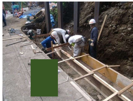
型枠製作・組立て
