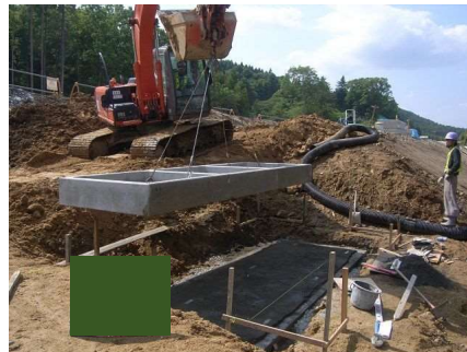
油水分離ます設置
