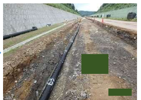
地下排水管設置
