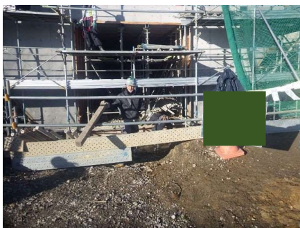
支保・型枠・足場撤去
