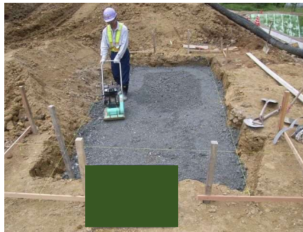
基礎材敷均し・締固め
