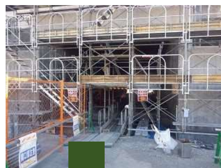
支保・型枠・足場撤去
