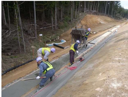
コンクリート打設
