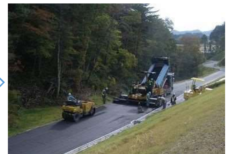
簡易舗装工（締固め）
