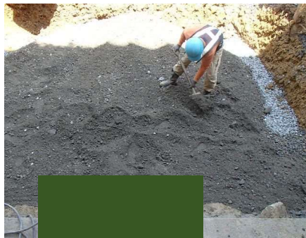
基礎材敷均し・締固め
