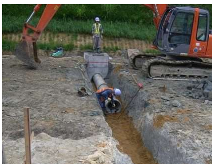
用排水管設置
