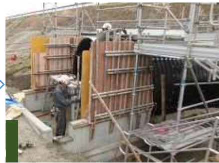
型枠組立②
