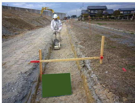
掘削・整正（床付）
