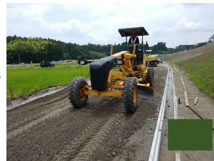
簡易舗装路盤工
