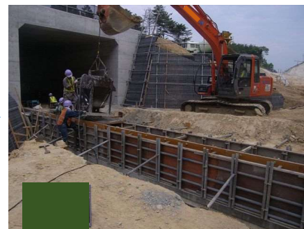
コンクリート打設
