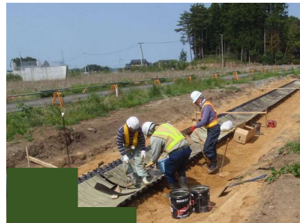
パイプ組立（ボトムセクション）
