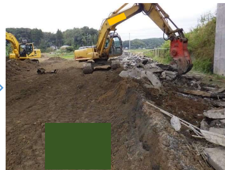
取壊し（圧碎機）
