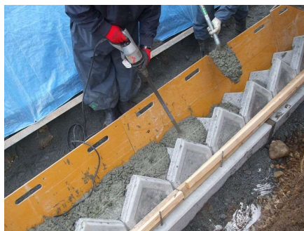
胴込め（※コンクリート打設の場合）
