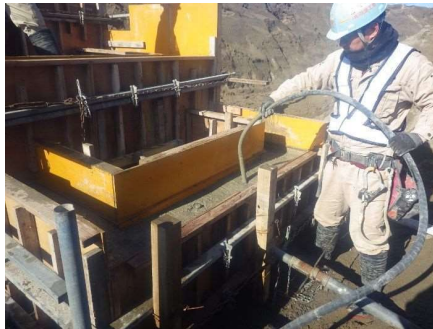
コンクリート打設
