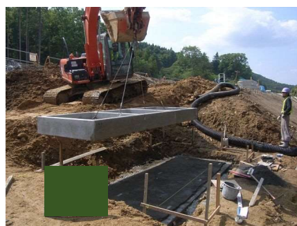
油水分離ます設置
