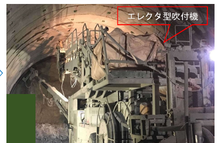
鋼アーチ支保工
