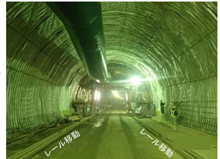
型枠移動 (養生完了後)
