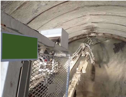
打設（フォアポーリング）
