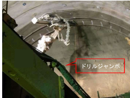
削孔（フォアポーリング）
