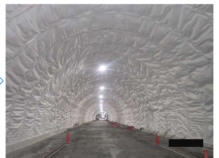
覆工防水工完了
