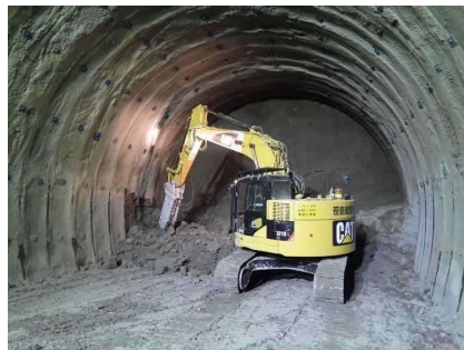
下半掘削（ブレーカ）
