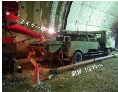
覆工コンクリート (打設)
