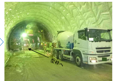
覆工コンクリート (ミキサー車)
