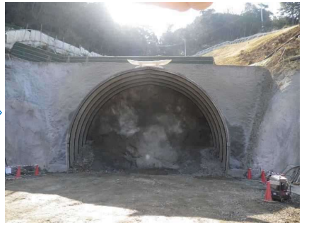
坑口切付け施工完了
