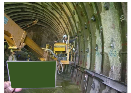
計測工B（地中変位測定）
