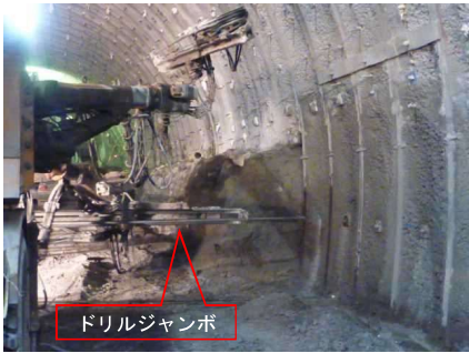
ロックボルト打設
