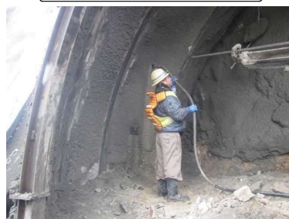
モルタル充填 (ロックボルト)
