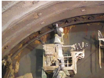
打設（フォアポーリング）
