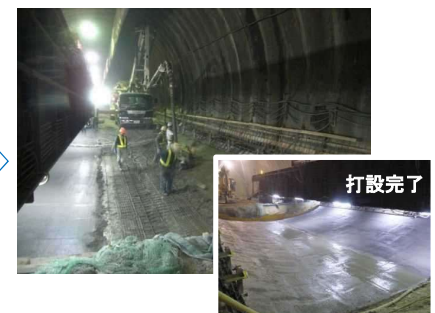
インバートコンクリート打設
