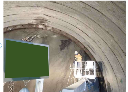
モルタル充填（フォアポーリング）
