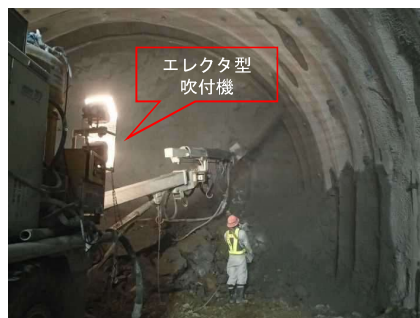
吹付コンクリート
