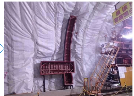
型わく据付 (箱抜き型わく)
