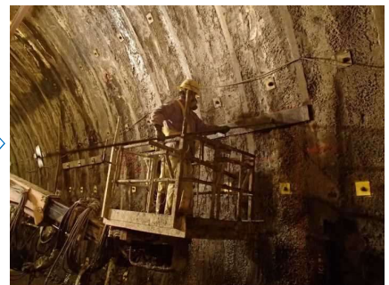
ロックボルト工（撤去）
