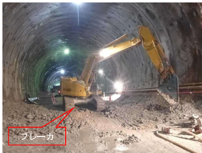
インバート掘削
