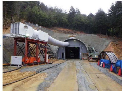
換気設備工（設置完了）
