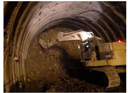
上半掘削 (油圧切削機)
