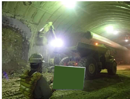
ずり処理 ( ずり 積 込 み )
