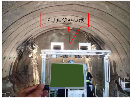
削孔（フォアポーリング）
