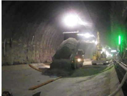
インバート締固め完了
