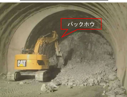
すり処理(すり積込み)
