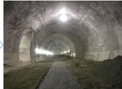
路盤排水工設置完了
