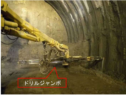
ロックボルト打設
