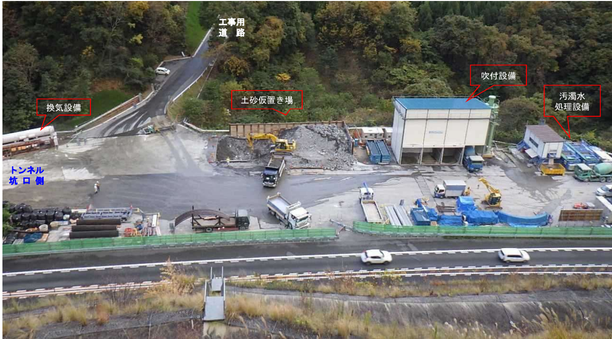
施工ヤード全景
