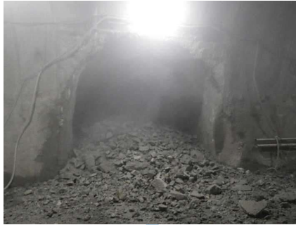
ずり処理 ( ずり 積 込 み )
