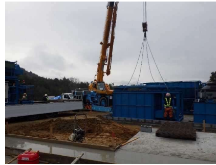
汚濁水処理工 (設置状況)
