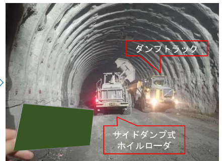
すり処理(すり積込み・運搬)
