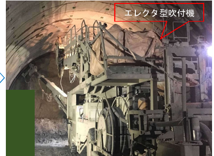
鋼アーチ支保工
