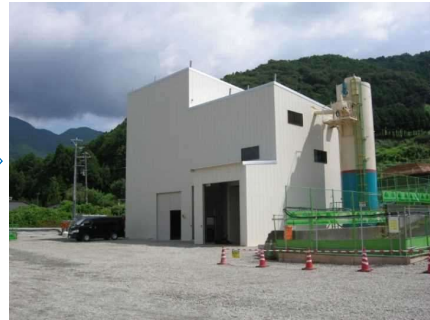
吹付設備工（設置完了）
