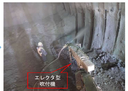
吹付コンクリート
