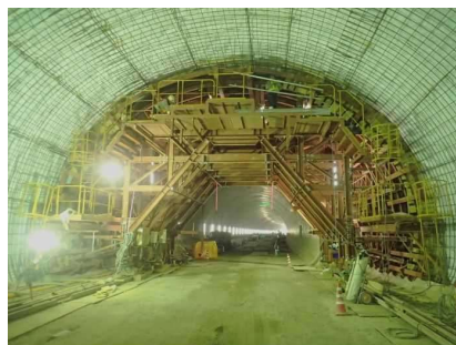
型わく据付完了
