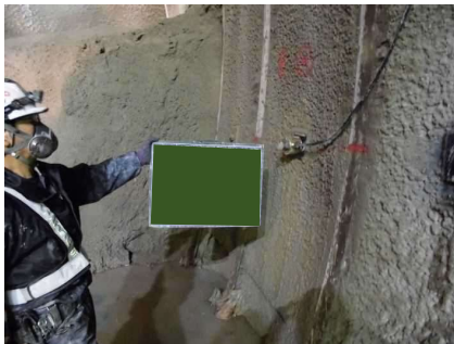
計測工B（ロックボルト軸力試験）
