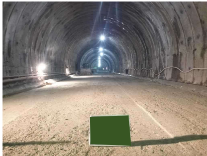
インバート締固め完了
