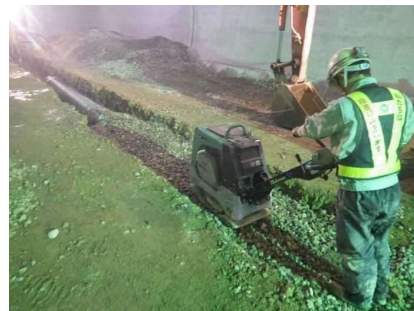
埋戻し材締め
