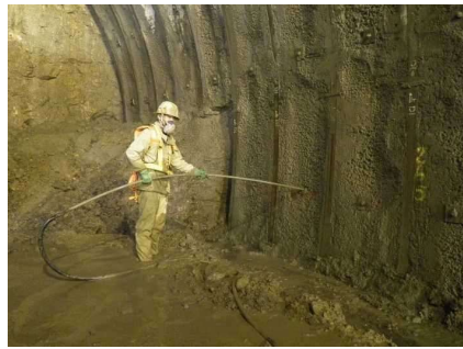
モルタル充填 (ロックボルト)
