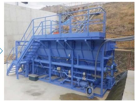
汚濁水処理工 (設置完了)
