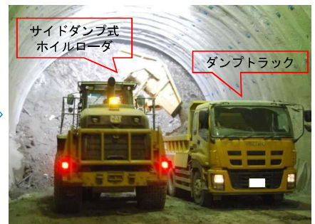
ずり処理（ずり積込み）
