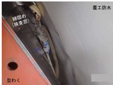
覆工コンクリート (打設)
