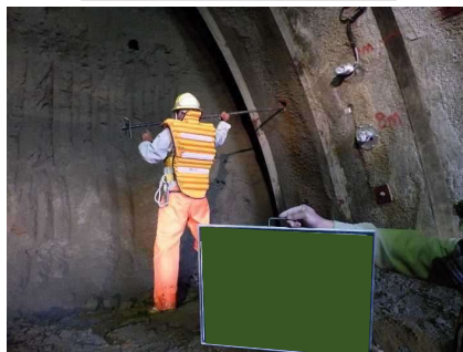
打設（ロックボルト）
