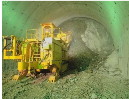
上半掘削 (トンネル掘進機)
