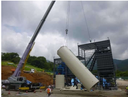
吹付設備工（搬入設置状況）
