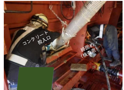
覆工コンクリート (打設)
