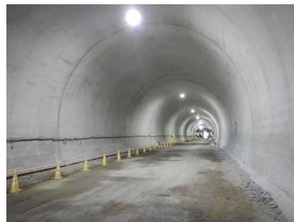
トンネル工完成
