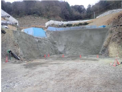
吹付コンクリート施工
