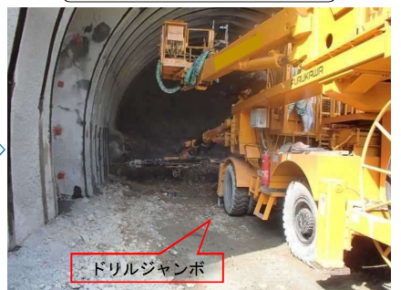
削孔 (ロックボルト)
