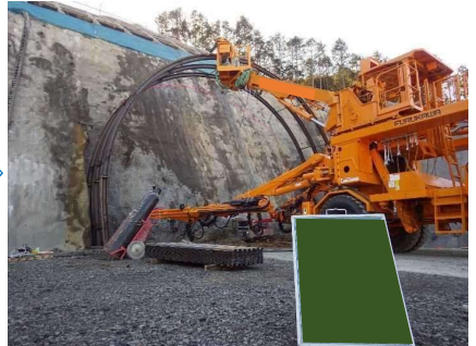
鋼アーチ支保工設置
