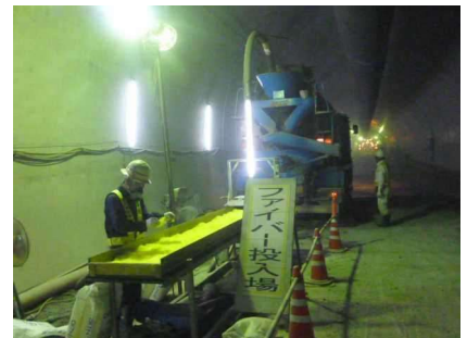
繊維現地混合 (覆工コンクリート)
