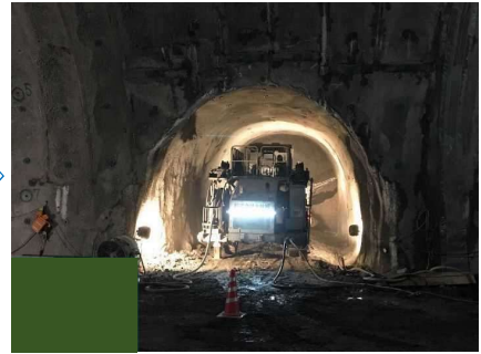
削孔 ( ロックボルト )
