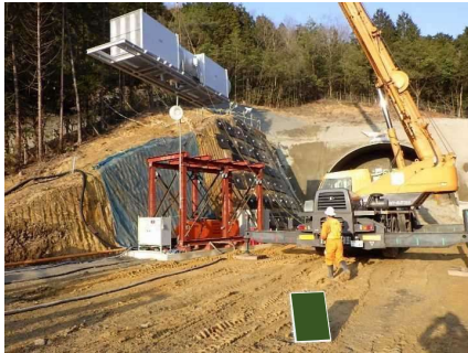
換気設備工（設置状況）
