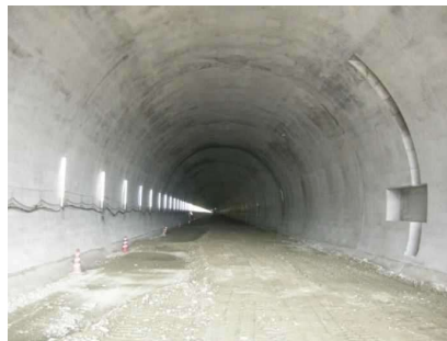
覆工コンクリート打設完了
