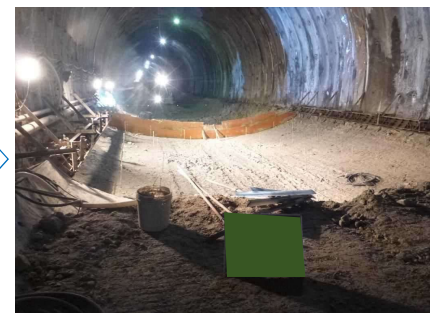
インバート型枠
