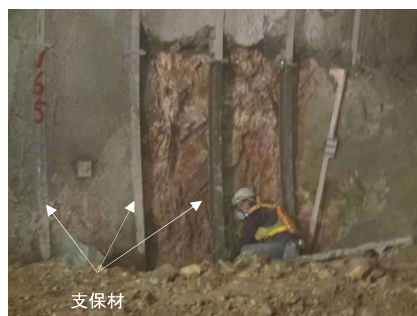
鋼アーチ支保工
