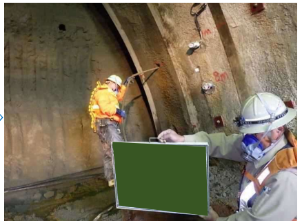
モルタル充填（ロックボルト）
