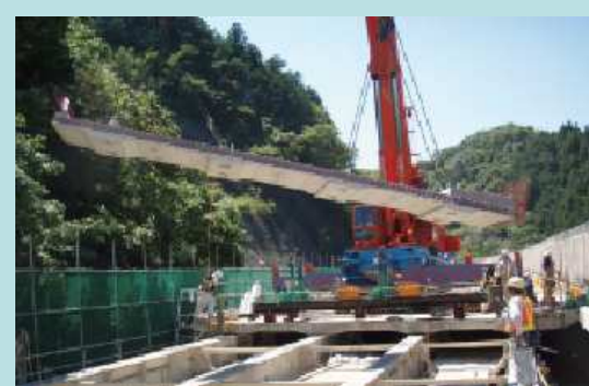
床版取替工事一例
