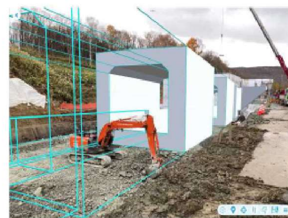
掘削作業時にARと比較
