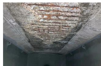
床版取替前(コンクリート床版下面)
