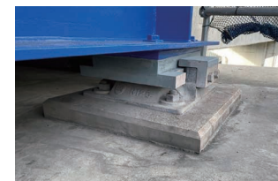
支承の取替前
