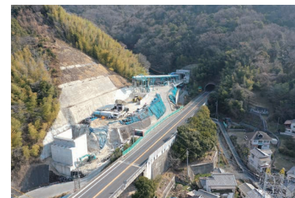
広島呉道路(吉浦大川橋)
