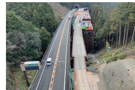
松山自動車道(橋本川橋)
