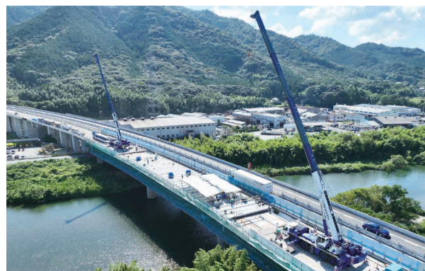
床版取替状況
