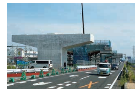
大和北道路(発志院北第一高架橋)
