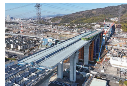
新名神高速道路(高槻高架橋)
