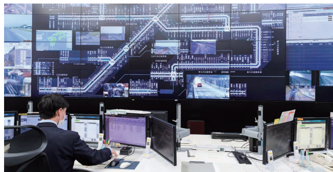
道路管制センター
