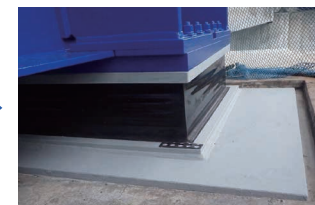
支承の取替後
