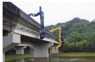
橋梁点検車による点検
