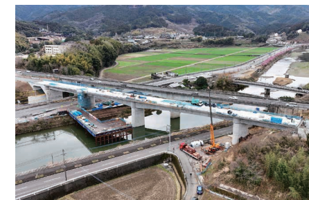
東九州自動車道(臼杵川橋)
