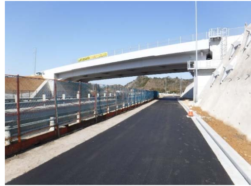
②ランプ部【本線合流部】
