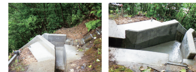
強化後の縦溝と集水ます
