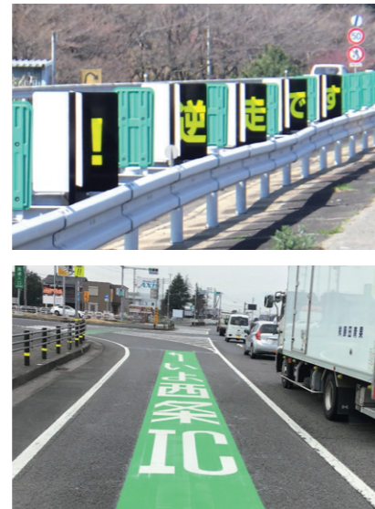
(上) 逆走車両に対する防眩板応用注意喚起 (下) 一般道接続部のカラー舗装 (逆走・誤進入防止)
