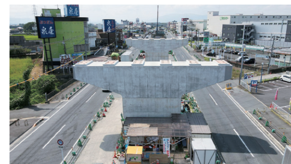
大和北道路 郡山下ツ道JCT付近
