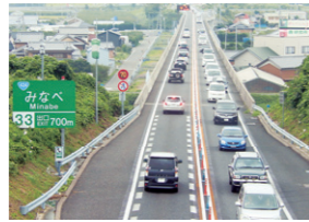
阪和道 印南IC～みなべIC
