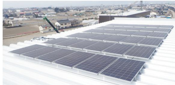
料金所の屋根に設置した太陽光パネル
