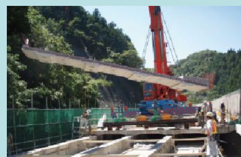
床版取替工事一例
